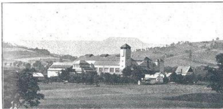
Elektrisches Kraftwerk Mittelsteine. (Geuscheuer im Hintergrunde.)
