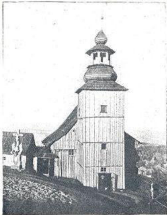
Dölzernes Bergkirchlein in Steinbach.
